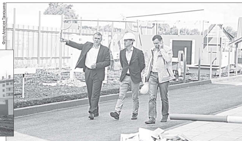
Работы по строительству детского сада в Криводановке — под контролем областного министра
