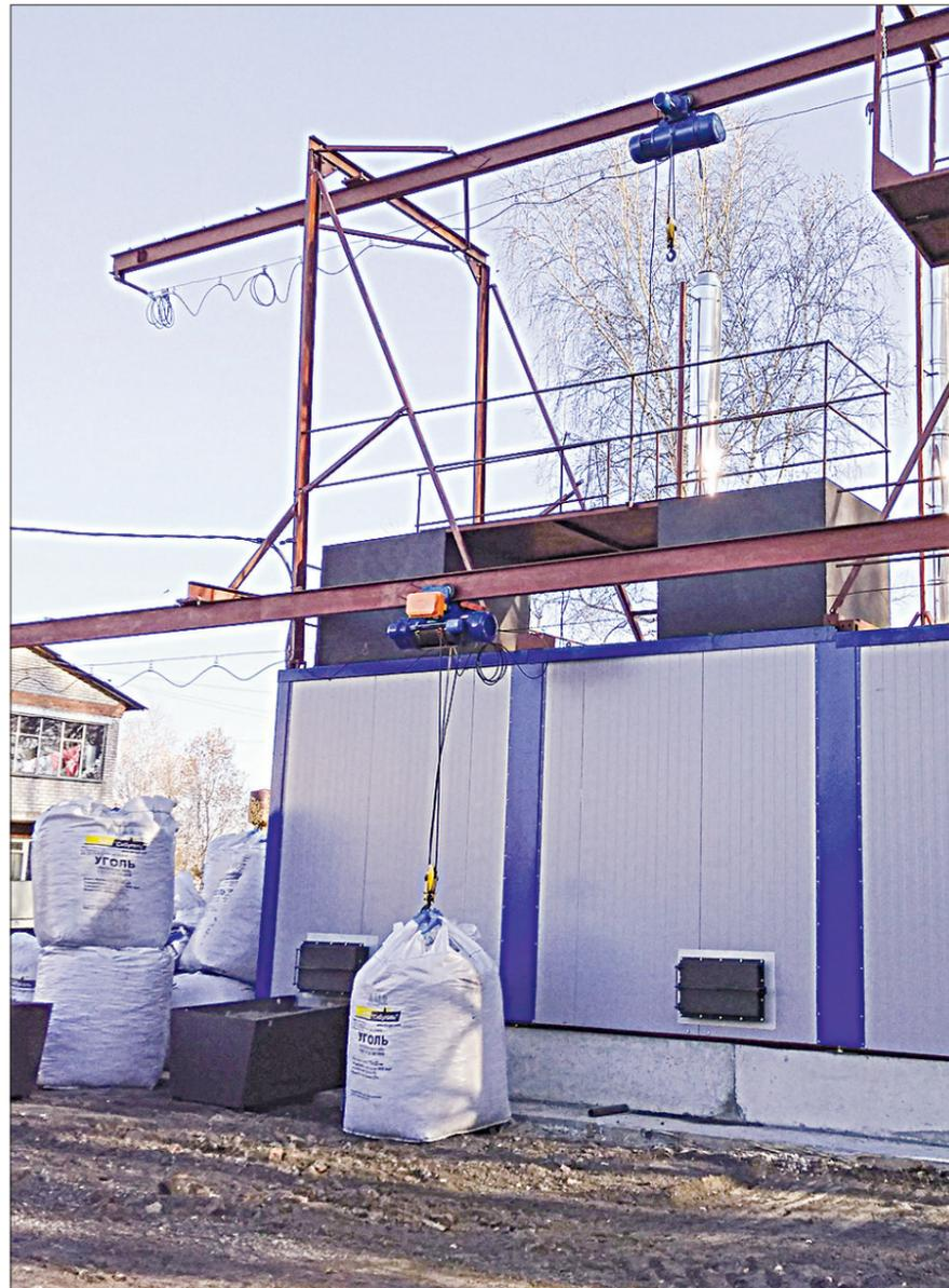
Раз в три дня бункер загружают: оператор цепляет мешок за кран-балку, и уголь высыпается внутрь. Осталось убрать шлак, чтобы увезти его на отвалы, и можно забыть о котельной еще на несколько дней
